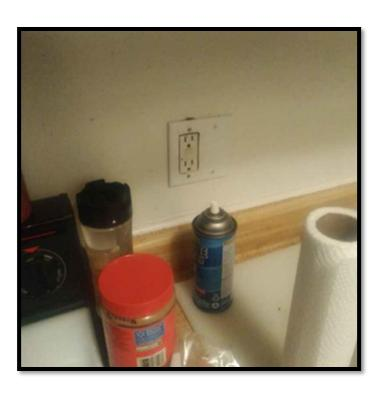
DEFICIENCY I — UNIT: GFCI OUTLET OR GFCI BREAKER IS NOT VISIBLY DAMAGED AND THE TEST OR RESET BUTTON IS INOPERABLE.
